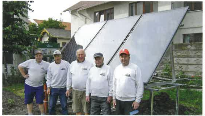
Endlich warmes Wasser im Kloster in Alba Julia. Nachdem man vor Ort das Fundament für die Solaranlage errichten hatte lassen, konnten die sechs Schwaben die Anlage Anfang Juni installieren und in Betrieb nehmen. Unser Bild zeigt von links Thomas Dempfle, Hermann Thalhofer, Peter Danner, Ewald Jergon und Martin Mögele. Der 2. Vorsitzende Ernst Ludwig stand hinter der Kamera.
